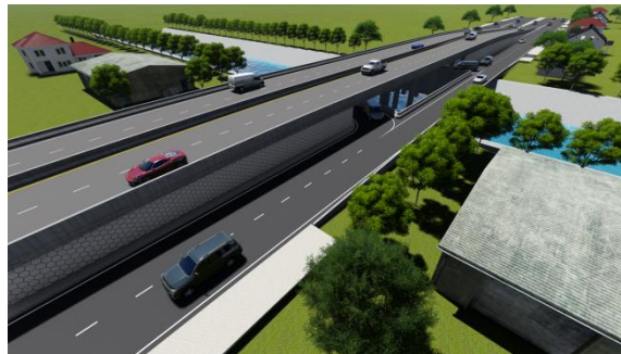
รูปที่ 4 จุดกลับรถใต้สะพาน
